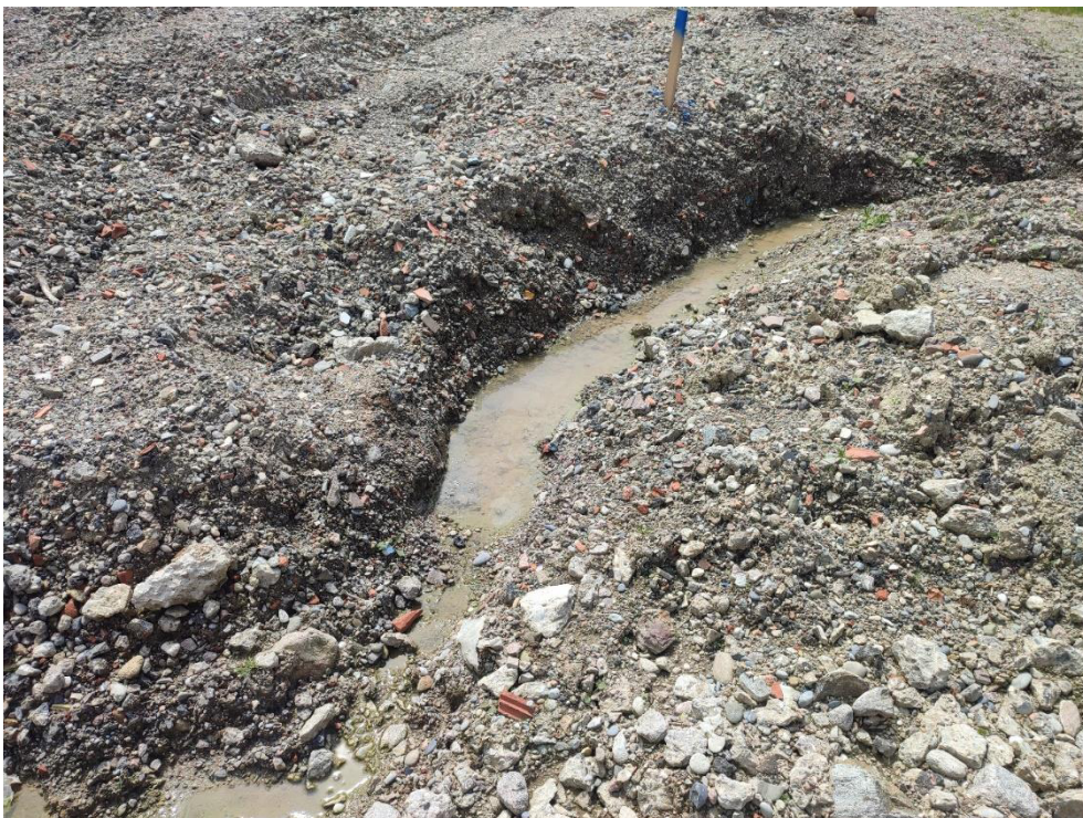
Abbildung 8: Mit Wasser gefüllte Fahrspurrinnen im Planungsgebiet.
