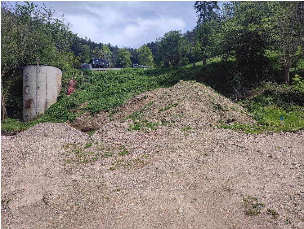
Abbildung 4: Blick auf geschotterte Fläche des geplanten Bauvorhabens mit teilweise bewachsenem Baumaterialhügel.
