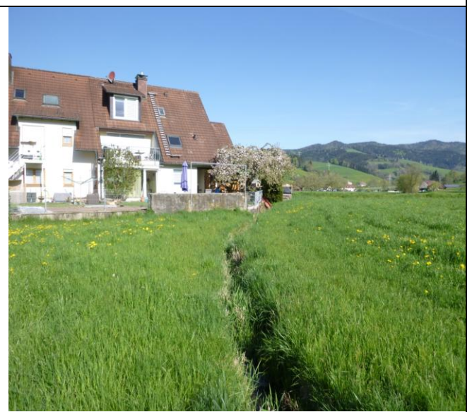
Abb. 8: Stegen-Oberbirken, Verlauf Fließgewässer Bereich 2 (Foto: Buck, 19.04.2018)
