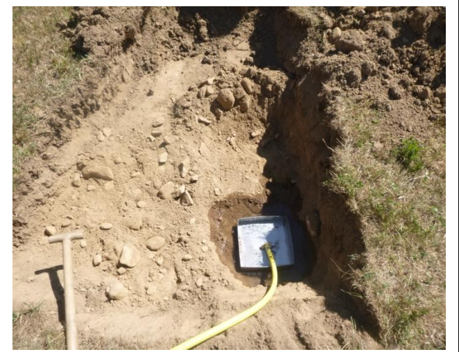
Foto 5: Schurf 4; Versickerungssohle 0,5 u.GOK Substrat: Schluff, feinsandig, schwach tonig, schwach kiesig (Foto: Buck, 30.07.2020)
