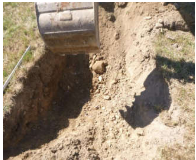
Foto 5: Schurf 5; Versickerungssohle 0,5 u.GOK Substrat: Schluff, feinsandig, schwach tonig, schwach kiesig (Foto: Buck, 30.07.2020)
