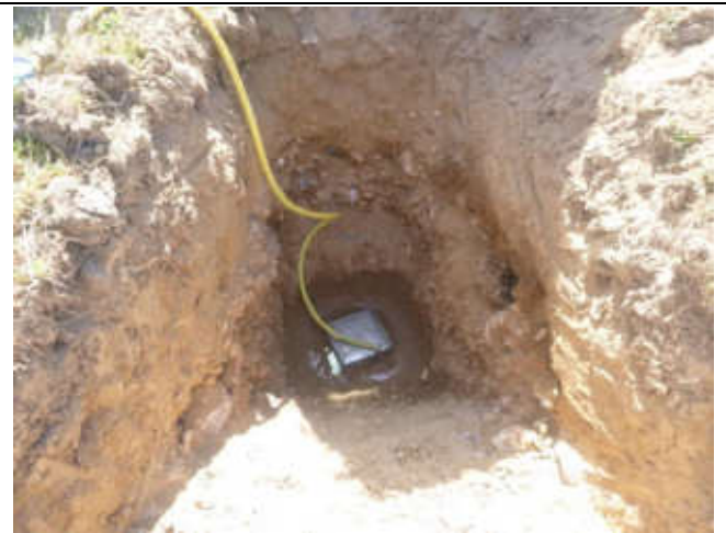
Foto 2: Schurf 1, Versickerungssohle 1,5m u. GOK Substrat: Kies, stark sandig, steinig (Foto: Buck, 29.07.2020)
