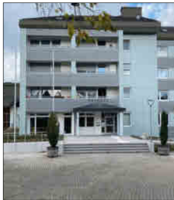
Das Rathaus in Stegen wird saniert.
