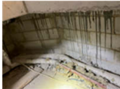
Defekter Wärmeschutz
