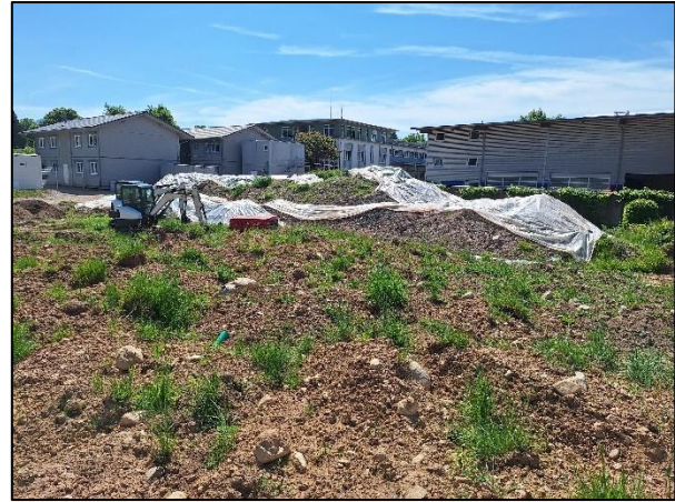
Abb. 5: Lagerfläche für Erdaushub westlich des Plangebiets.
