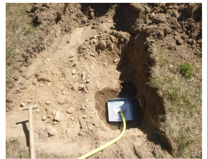
Foto 5: Schurf 4; Versickerungssohle 0,5 u.GOK Substrat: Schluff, feinsandig, schwach tonig, schwach kiesig (Foto: Buck, 30.07.2020)
