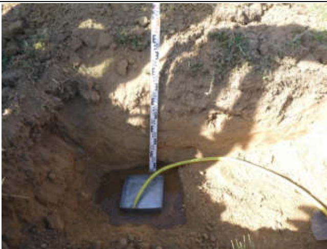
Foto 1: Schurf 1, Versickerungssohle 0,6m u.GOK Substrat: Schluff, sandig bis stark sandig, schwach kiesig (Foto: Buck, 29.07.2020)
